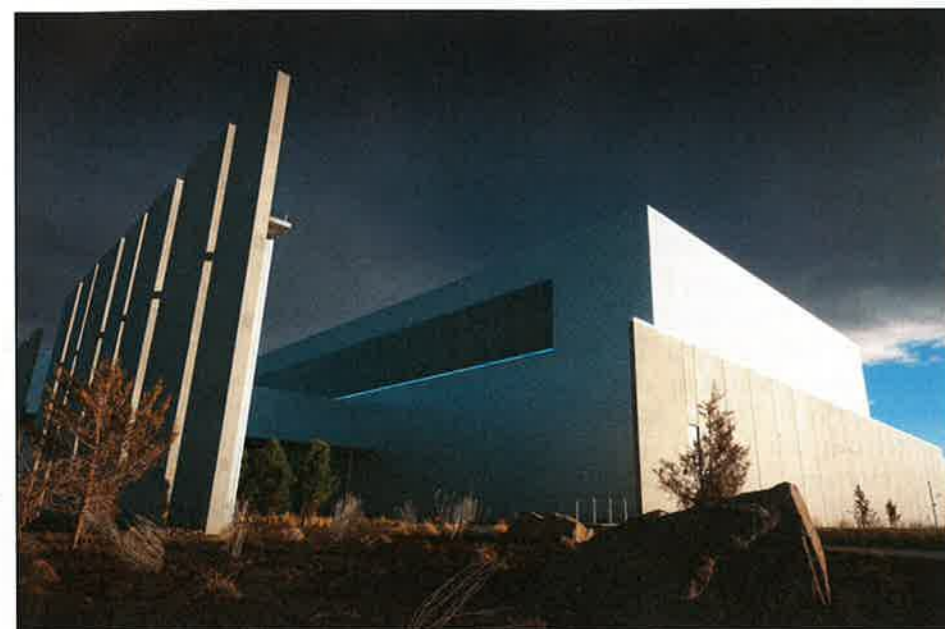
Bâtiment dédié à la gestion des données informatiques : un datacenter de Facebook.
